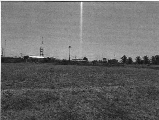
Foto 09: Vista lateral- Estádio
