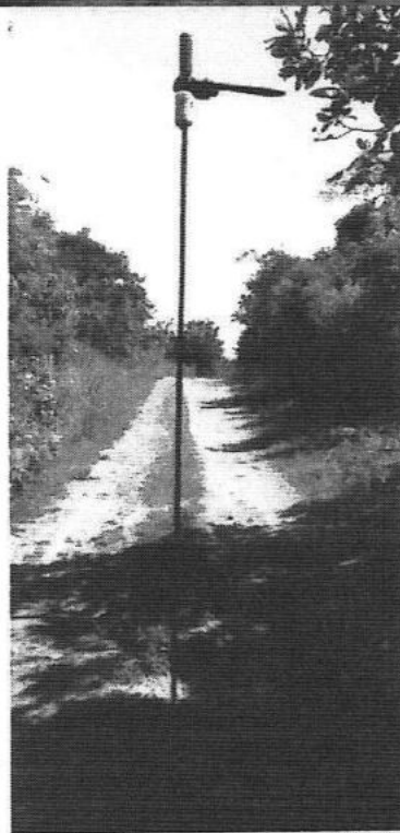
Fotos 07 e 08 – Sondagem em S 05 com Profundidade de 2,30m.
