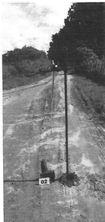
Foto 04 – Sondagem em S 02 com profundidade de 0,50m.
