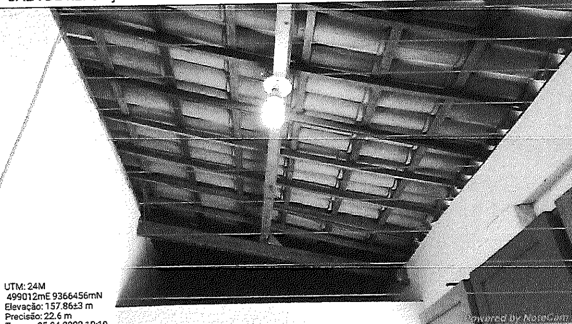
Figura 44 Imagem referente à Sala de Reforço - Coberta
